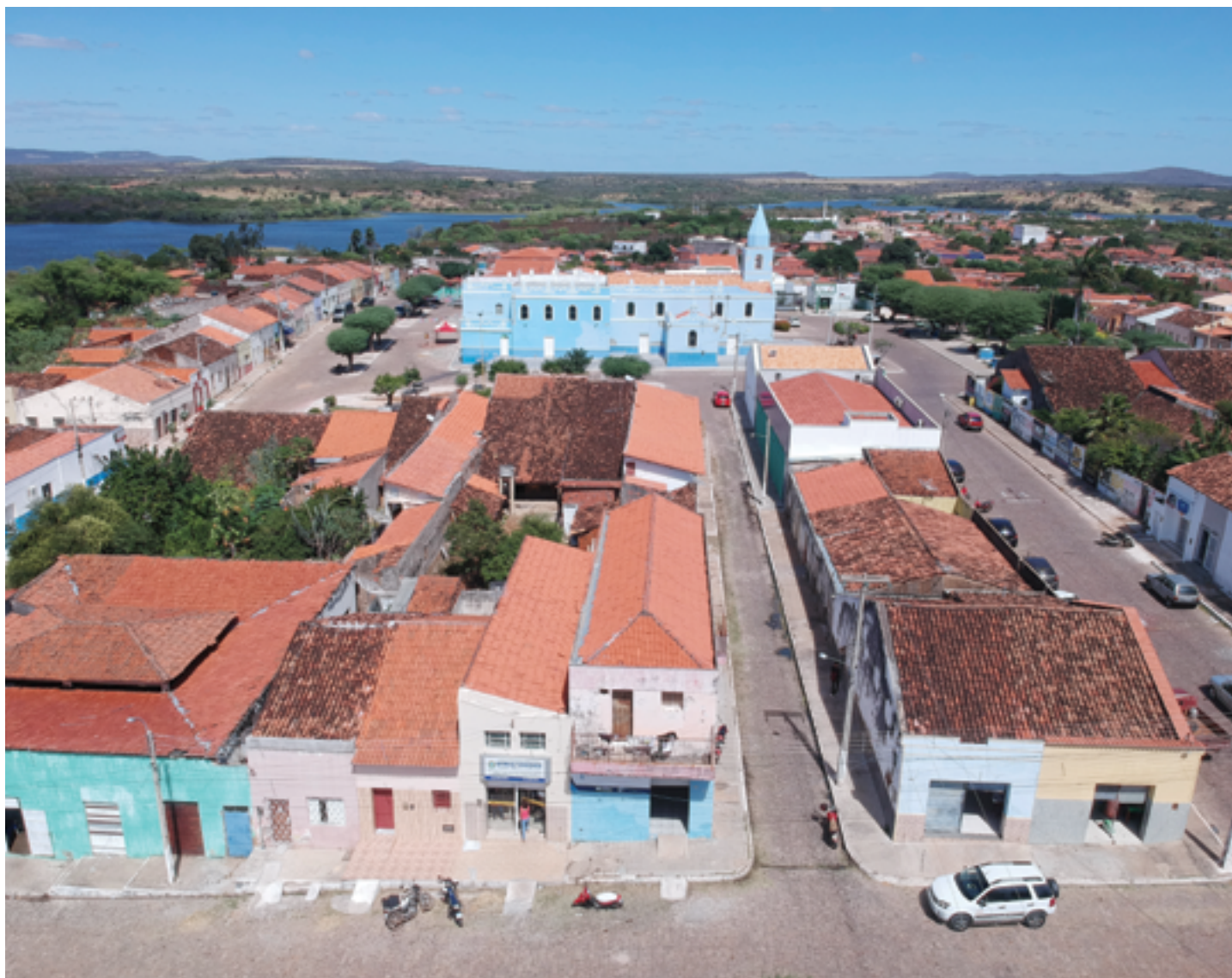
O Cartório de Paulistana, de 1889, é um dos mais antigos do estado. Foi erguido no entorno da Paróquia de Nossa Senhora dos Humildes e é contornado pelo açude Ingazeiras, com capacidade de acumular 25 milhões de metros cúbicos de água (m 3 ).
